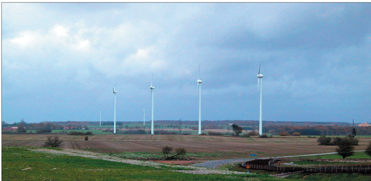
Vindkraftverk på Eslövsslätten
