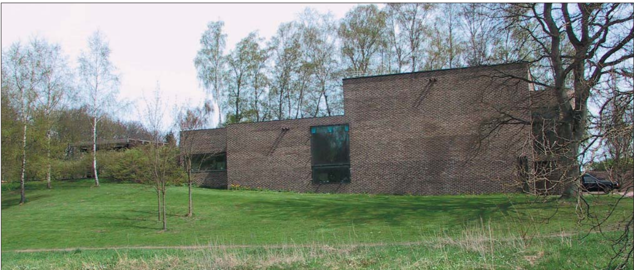
Klockarebackens kapell är ritat i en stil som kan betecknas som poetisk nybrutalism och utgör ett av de mer sublimes byggnadsverken i det skånska landskapet
