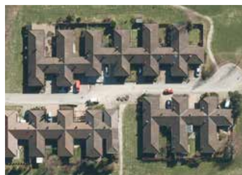
Enplansvillor byggda 1970 sedda från ovan
