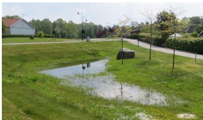
Figur 2. Fördröjningsyta för dagvatten.
