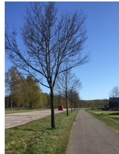
Figur 3. Dike med trädplantering mellan väg och cykelväg.
