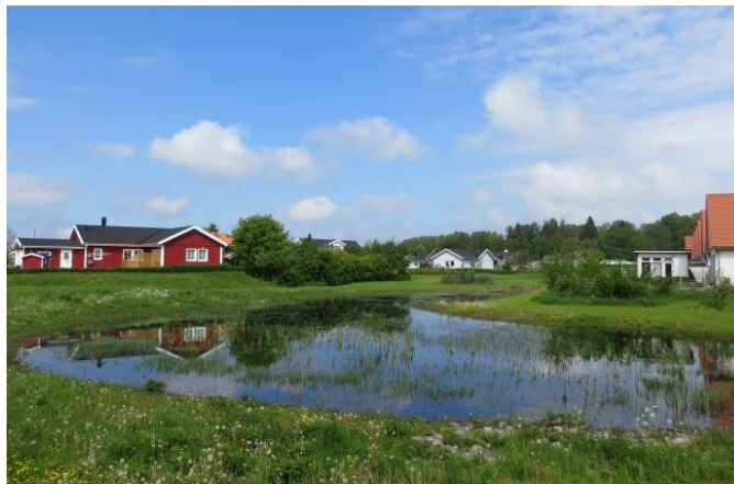
Figur 1. Fördröjningsyta för dagvatten.
