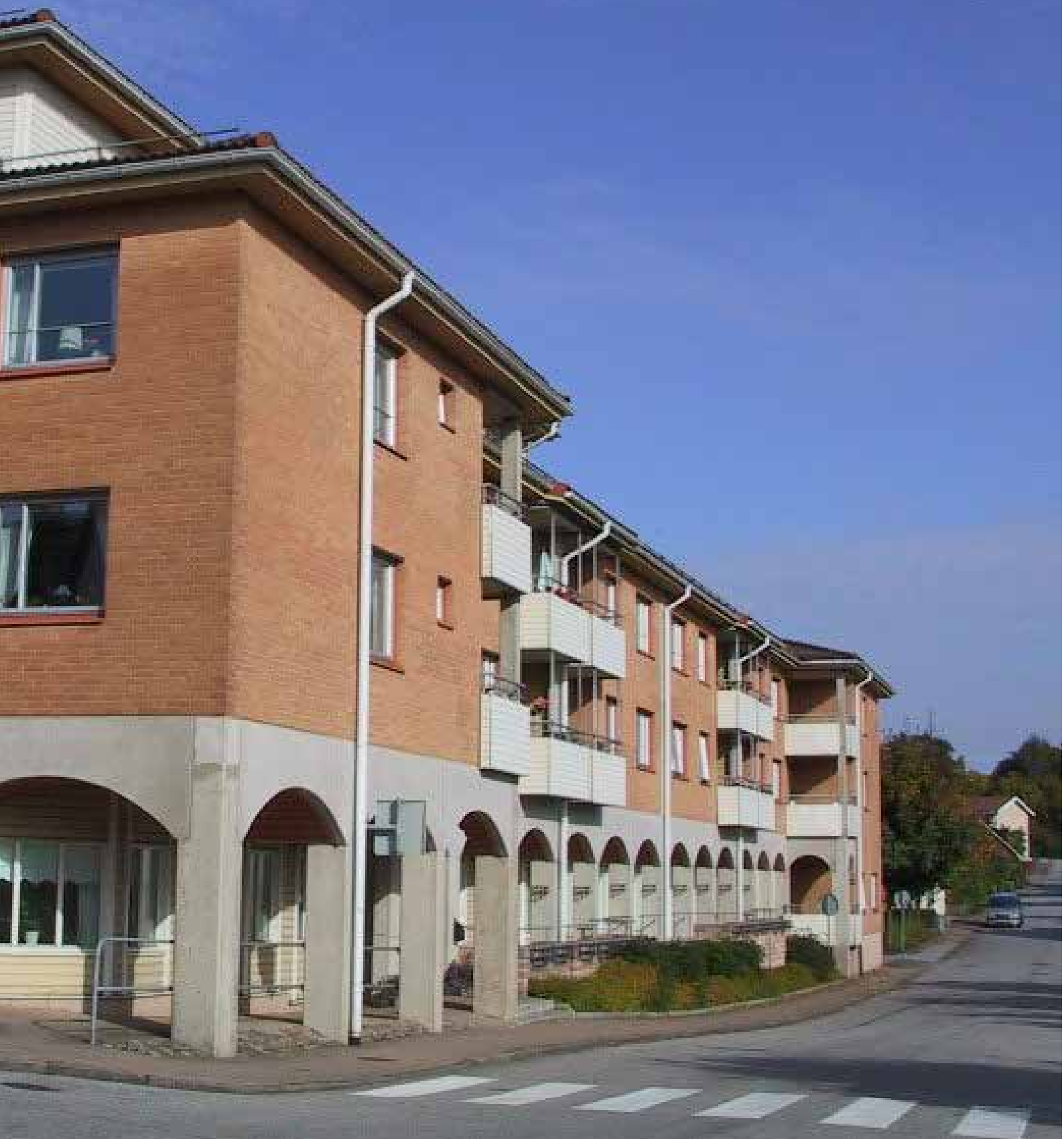
Trygghetsboendet Kungshällan byggt 1984
