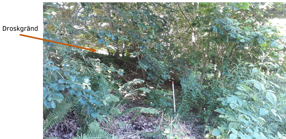
Foto som visar den nivåskillnad som är inne på Droskan 9 mot Droskgränd.
