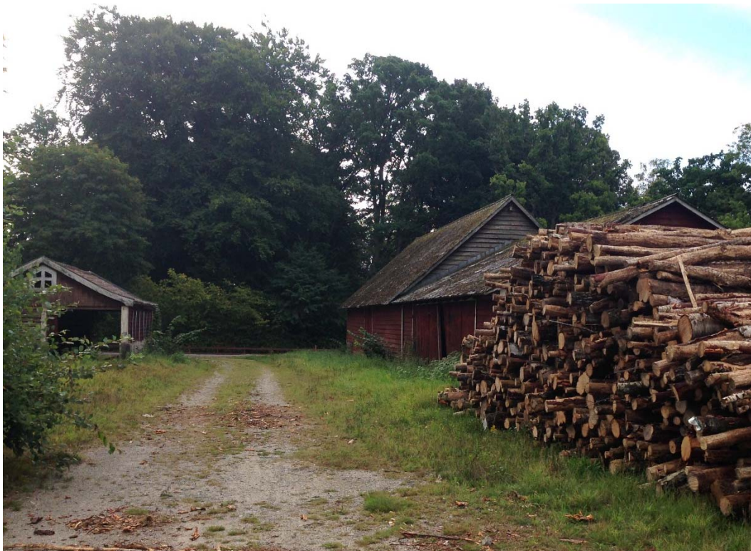
Figur 2. På fastigheten Sätofta 18:53 finns det två sammanbyggda trälador och en mindre träbyggnad med stensockel. Utanför bild, till vänster om den mindre byggnaden, ligger en stenbyggnad.
