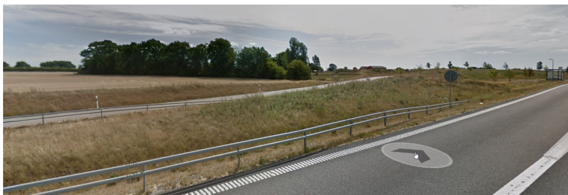
Figur 24. Vy från E22 mot sydväst och befintlig vall vid busshållplatsen, källa Google Maps.
