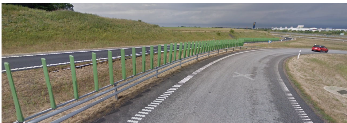
Figur 26. Exempel bländskydd placerat på räcke, källa Google Maps.
