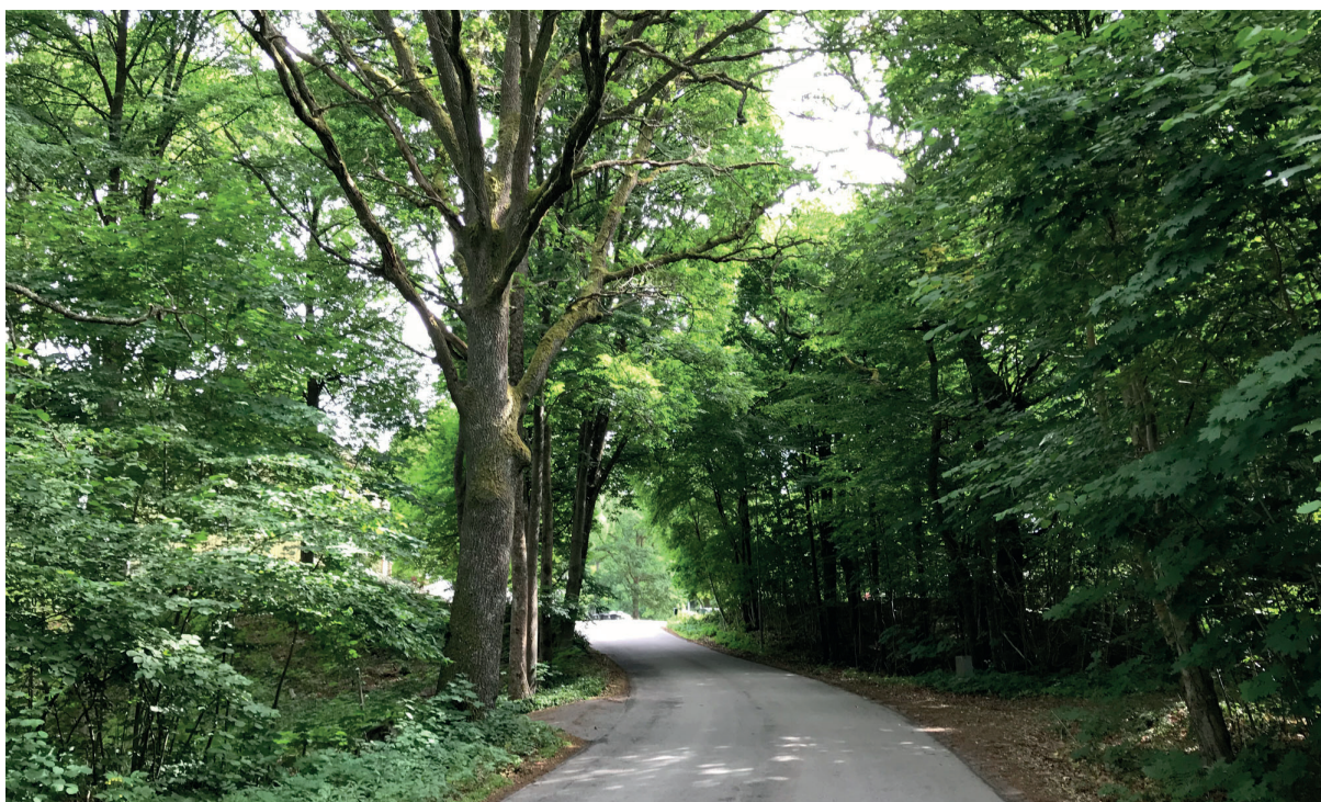
Den befintliga utfarten som kommer anpassas till den nya asfaltskanten syns på vänster sida av Hörbyvägen på bilden.
