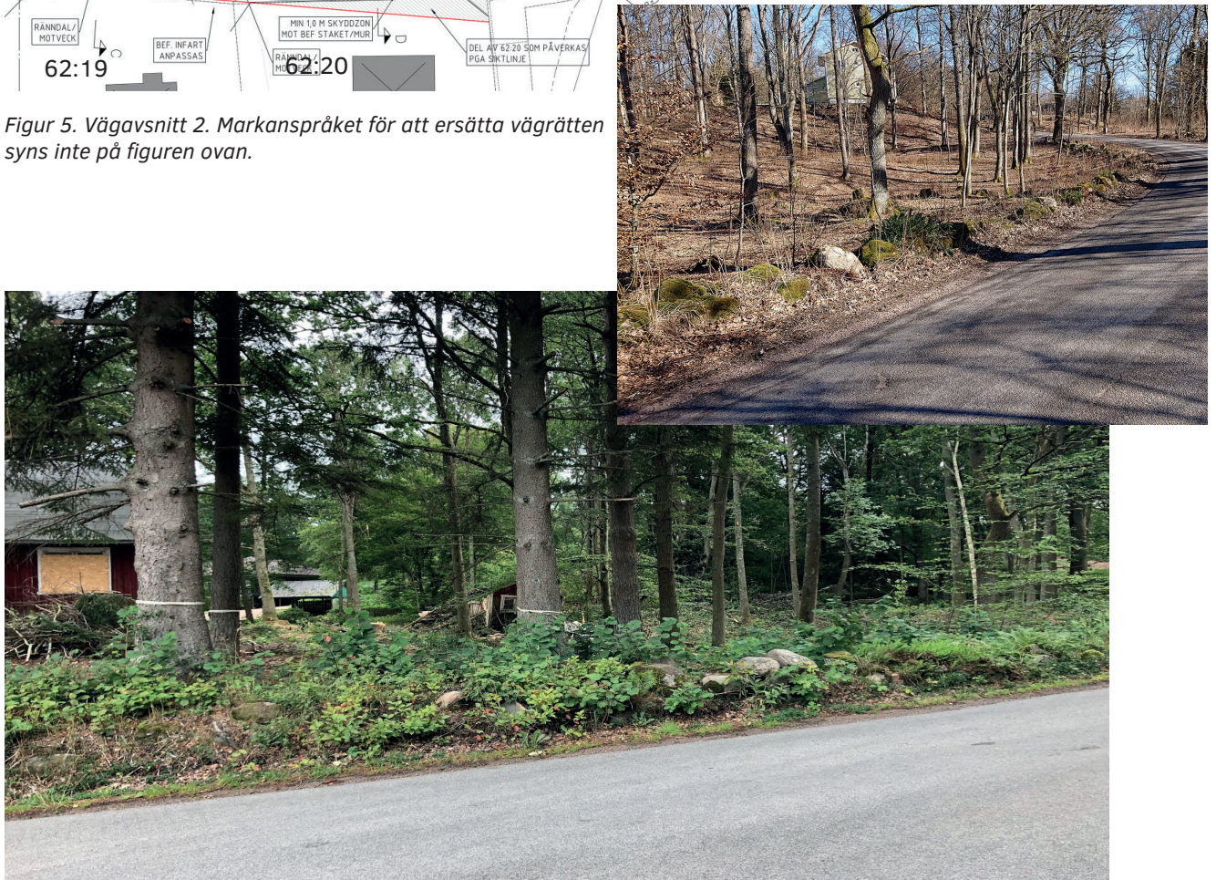
Foto från Hörbyvägen in mot fastigheten Höör 62:17 (innan byggnaden revs). Den mindre bilden är efter att byggnaden rivits
