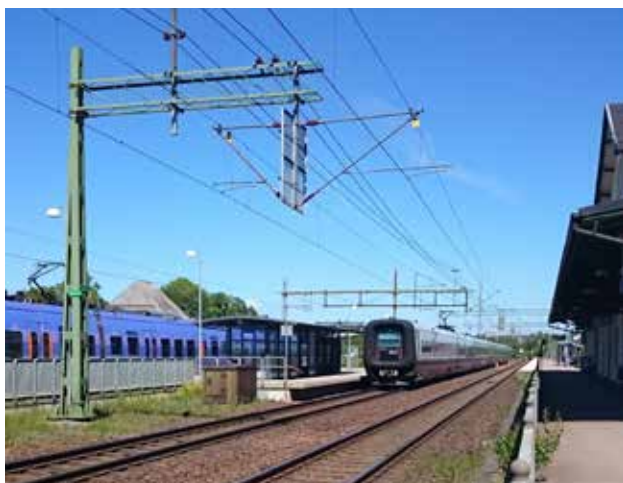
Figur 12. Bullerstörningar från den närläggna tågstationen.
