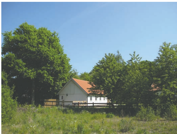
Bild 23, Förtätningen med den nya förskolan innebär att den nya bebyggelsen kommer tätare inpå den befintliga, som byggnaden på bilden som är belägen strax öster om den föreslagna förskolan där det bedrivs vårdhem.
