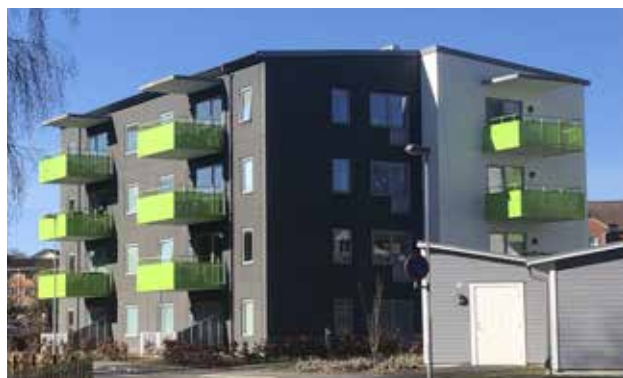
Luftigt flerbostadshus i centrala Höör
