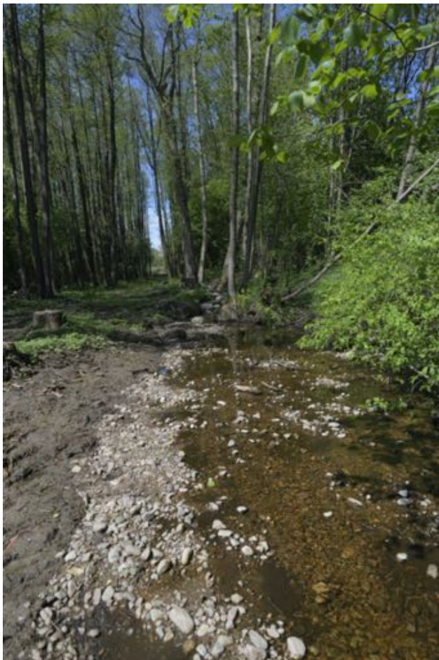
Figur 12. Restaurerad grussträcka i övergången mellan stark till svag lutning (nedströms sektion Ö5/Ö6).
