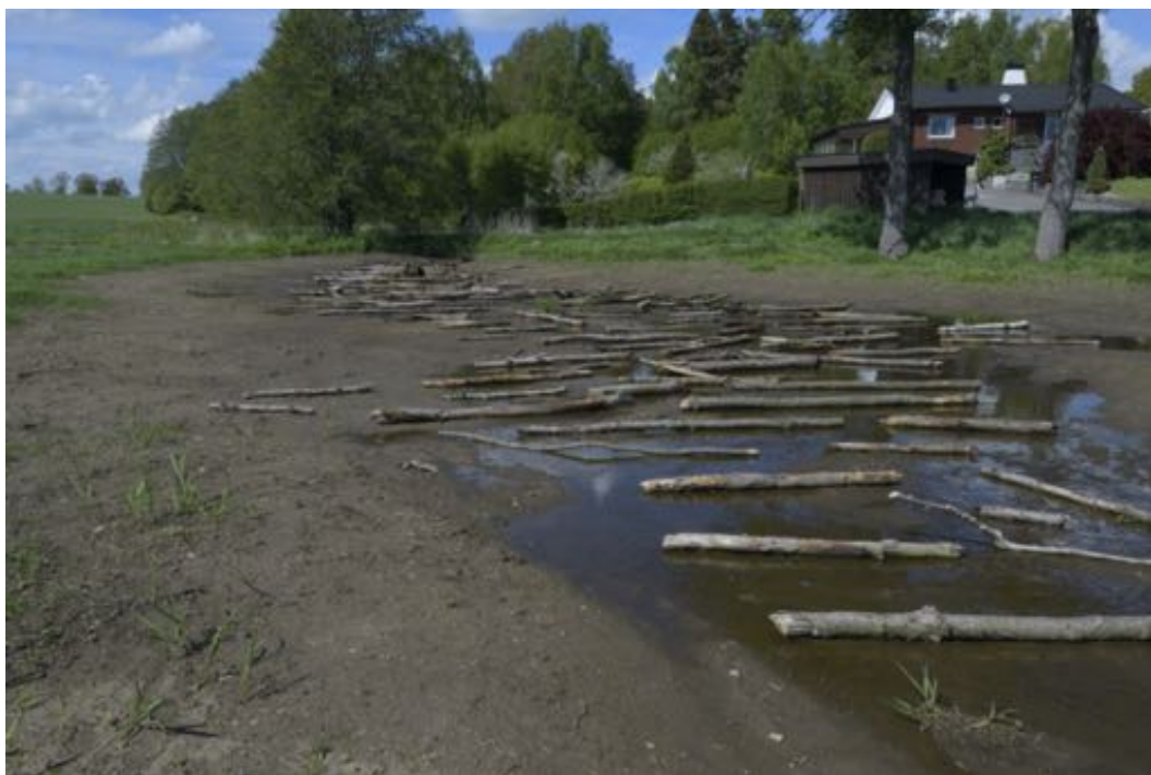
Figur 13. Restaurerad del av vattendraget med "Stage Zero Concept", som innebär att man ger vattendraget ett fritt spelrum för att över tid kunna utveckla en egen fåra belt i dynamisk jämvikt med kringliggande mark. Iläggning av död ved fungerar som en accelerator för utveckling av den nya åfåran. Platsen ligger vid sektion Ö7/Ö8 och i förbindelse med denna yta ligger en våtmarksyta som omedelbart vid högre flöden integreras i svämplanet.
