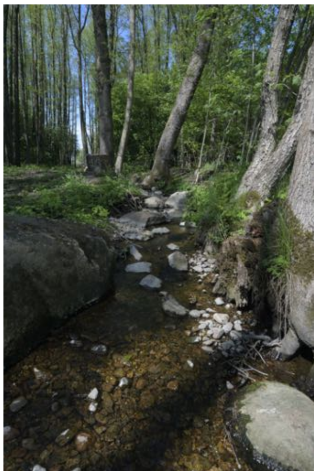
Figur 9. Restaurerad sten- och blockrik sträcka i östra diket vid sektion Ö5/Ö6. Tidigare var här en djup och rätad dikesfåra utan sten och grus. Genom höjning av bottennivån och införande av strukturer som block och stenar så kan vattnet vid höga flöden åter översvämma kringliggande svåmytor.
