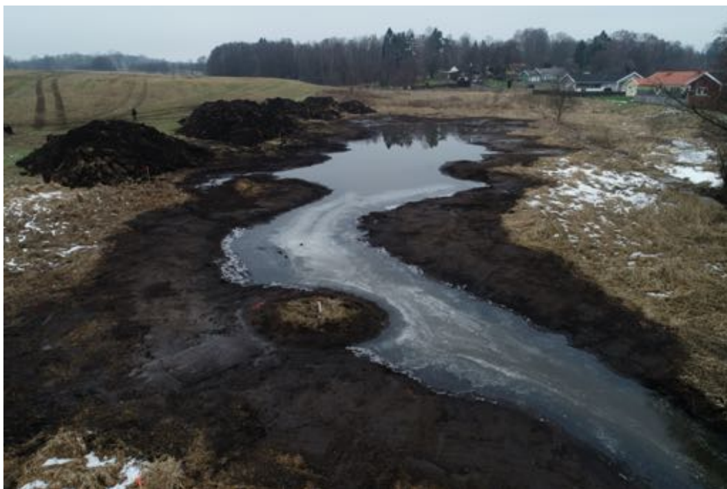
Figur 14. Översiktsbild från drönare under arbetets gång med den stora våtmarken i Östra diket.
