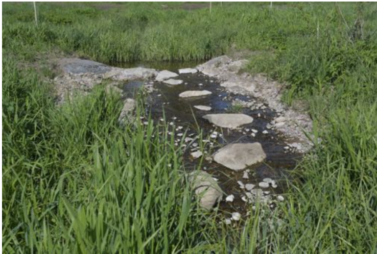
Figur 11. Stenträskel nedströms sektion Ö3/Ö4 som utformats i natursten och med en utdragen fallprofil för naturlighet och passerbarhet. Den säkerställda basnivån är helt avgörande för den önskade hydromorfologiska dynamiken i uppströms område. Liknande träsklar har anlagts nedströms alla våtmarker.
